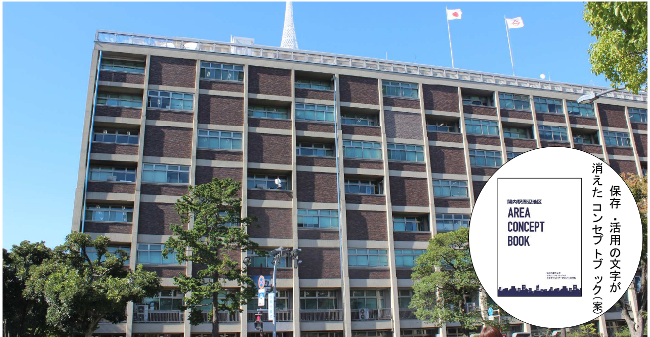
写真：現市庁舎
